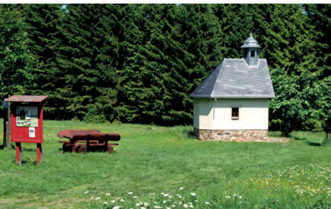
Die wiederaufgebaute St. Nepomuk-Kapelle im Erzgebirge zwischen Breitenbrunn / Sachsen und Gottesgab (Boží Dar) / Tschechien.
