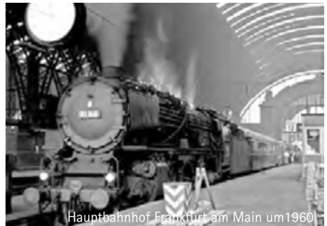
Hauptbahnhof Frankfurt am Main um 1960
