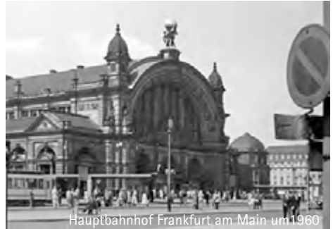
Hauptbahnhof Frankfurt am Main um 1960
